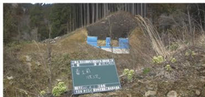
着工前(平成21年4月)
